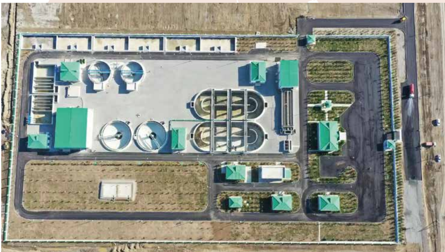
ATIK SU ARITMA TESISI WASTEWATER TREATMENT PLANT СТАНЦИЯ ОЧИСТКИ СТОЧНЫХ ВОД
